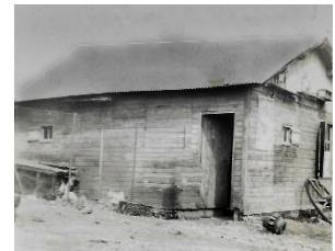
Maison provisoire qui se trouvait au 11 rue Saint-Eloi
